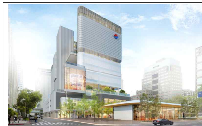
원동백화점 신의A13 전경
